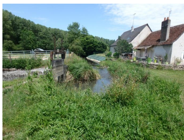
Dérivation de la Choisille au lieu-dit « Villiers »
