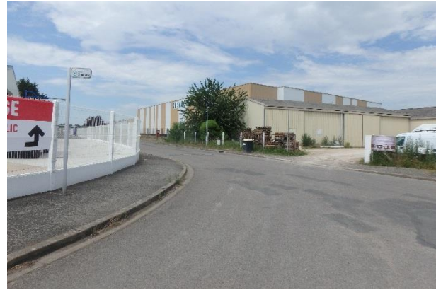
Zone industrielle des Gaudières
