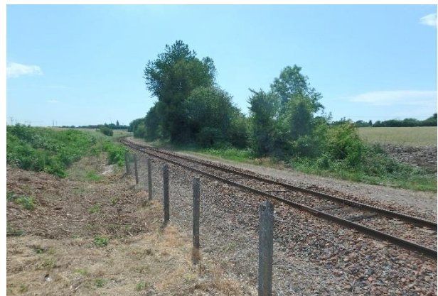
Voie ferrée au sud du territoire
